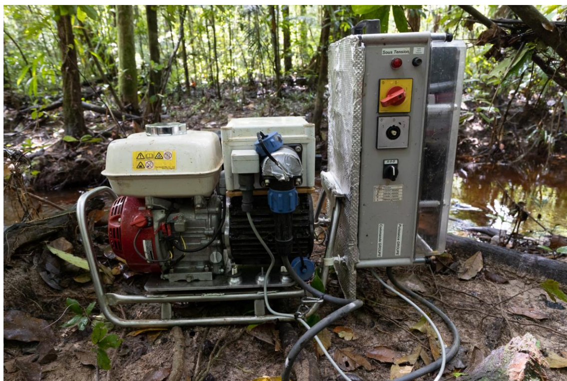
Figure 2. Le Patagari constitué du groupe électrogène et du boîtier de conversion et régulation du courant.
