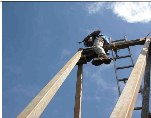
Démontage de la chèvre, pylône 'A', par Jacques Bonnefille, à 45 m de hauteur (20/4/2005).
