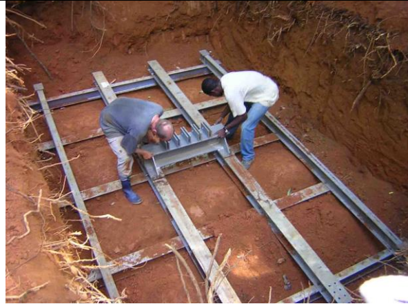
Début de montage d'un caisson, fixation du bloc d'attache des tiges soutenant les haubans (Gilles Peroz et Wémo Bétian).
