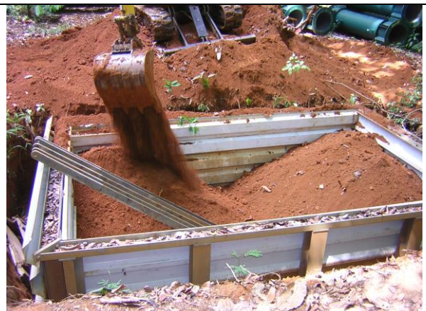
Remplissage d'une partie du caisson. Le remplissage définitif n'est effectué qu'en fin de construction du pylône.
