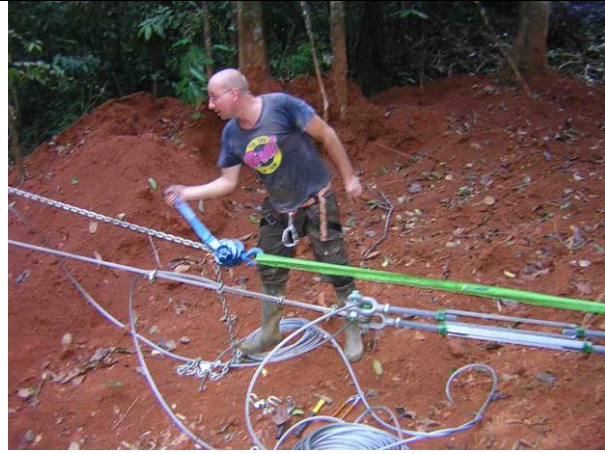
Réglage de la tension d'un hauban à l'aide d'un treuil à chaîne (Holger Teichert, étudiant d'Ulm, 8/12/2004)
