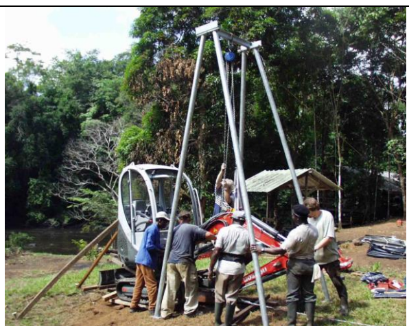
Saut Pararé, remontage de la pelleuse.
