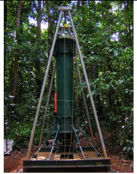
Fixation du premier élément. Remarquer le treuil de levage situé sous la chèvre, et les ridoirs de stabilisation permettant de régler la verticalité.
