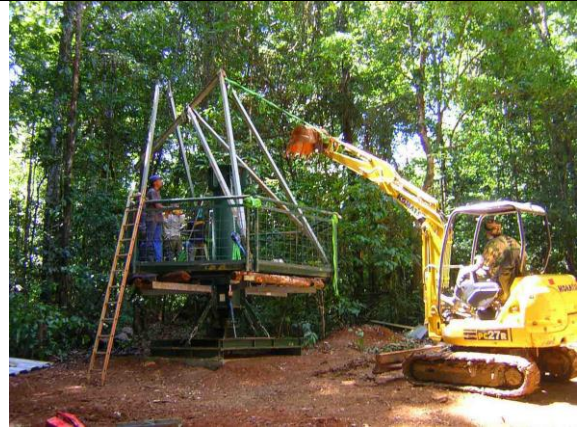
Mise en place de la chèvre sur la plate-forme du pylône 'C' (3/12/2004).
