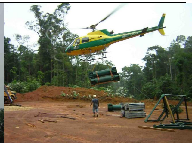
Piste de Bélizon, transport d'éléments de pylônes.
