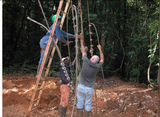
Transfer de câbles et réglages de la tension. De gauche à droite, Pierre Koesse, Eugène Joseph, Gilles Peroz (24/2/2005).
