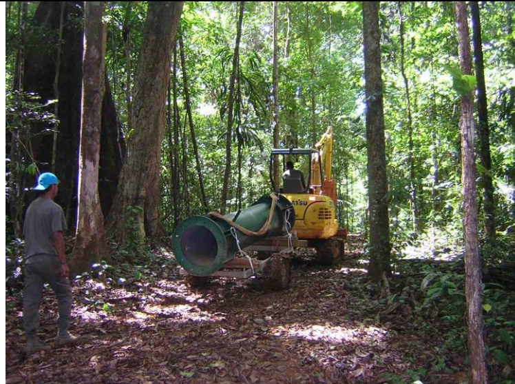
Chaque élément de pylône pèse 357 kg et mesure 2,80 m de long sur 57 cm de diamètre. Ils étaient transportés un par un et stockés près du site de montage, au fur et à mesure des besoins.
