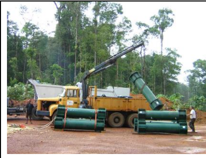
Piste de Bélizon, déchargement des éléments de pylônes
