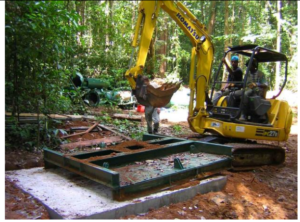
Positionnement du socle sur la dalle de béton. Remarquer la nouvelle pelleuse, la précédente ayant été détruite par les garimpéros .
