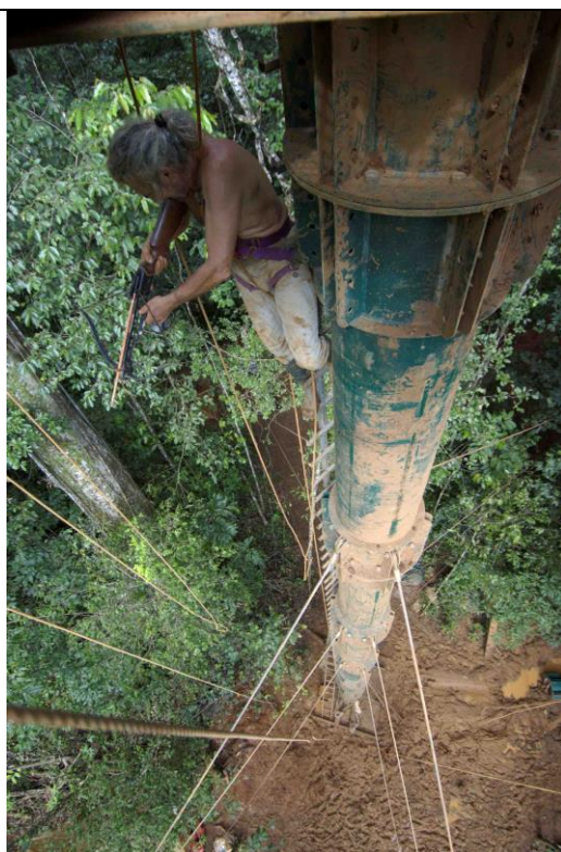
A gauche, envoi d'un filin à l'arbalète à partir de la plate-forme (Gilles Peroz, 28/02/2005). A droite, à partir d'une certaine hauteur il fallait se placer sous la plate-forme pour être dans l'axe du hauban (Jacques Bonnefille, 11/5/2005, photo Roger Leguen).
