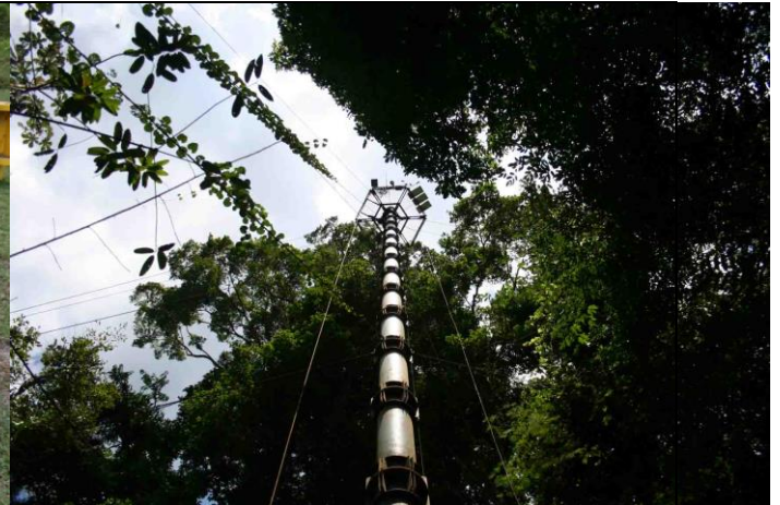
Pylône 'B', cinq ans après son installation. Remarquer certains capteurs installés sur le balcon (16/10/2010).
