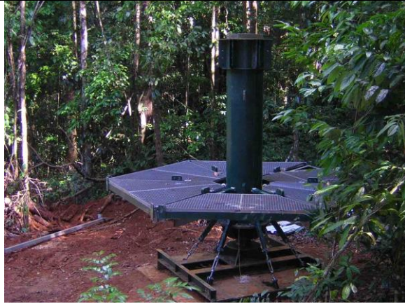
Mise en place de la plate-forme, Pylône 'C' (27/11/2004).
