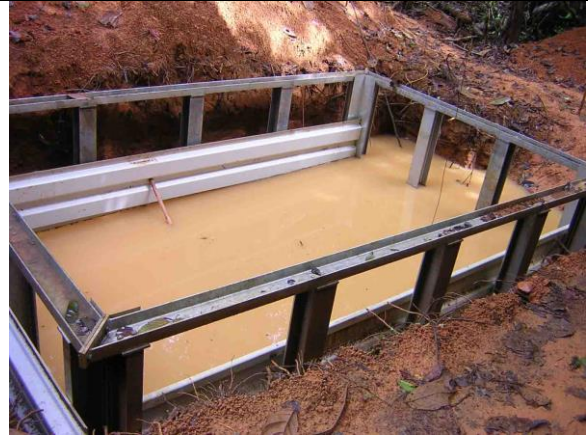
Caisson rempli d'eau après les grosses pluies d'avril 2004.
