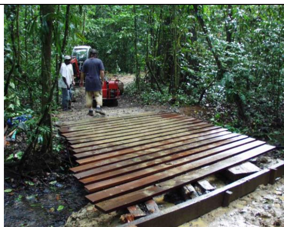
Construction d'un pont
