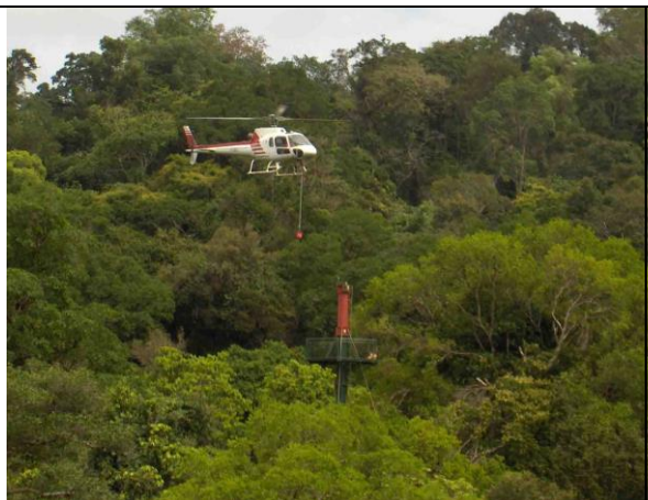
Approche d'un pylône pour y déposer un lest.
