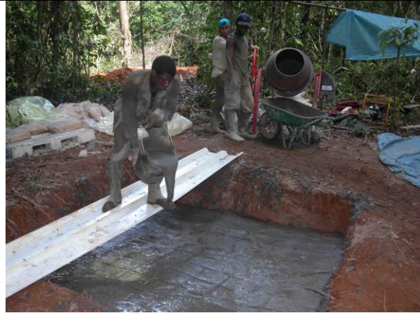
Préparation de la dalle de soutènement du pylône (trois couches de ferrailage et 80 cm d'épaisseur de béton sont nécessaires).
