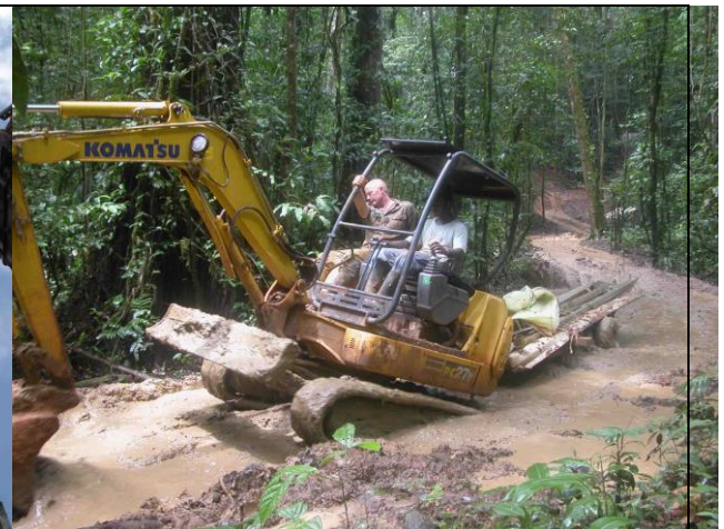
Passage de la pelleuse après de fortes pluies (3/3/2005).
