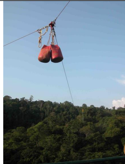
Lest placé à la jonction des trois câbles. On aperçoit, au fond, le pylône 'A', jaune, photo prise du pylône 'C'.
