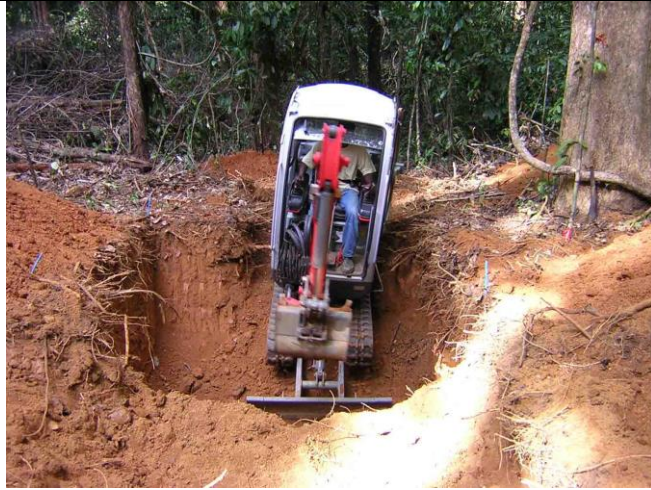
Entame de la première fosse, (futur pylône 'C').
