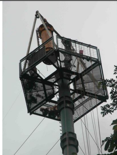
Montage du seizième et dernier élément sur le pylône 'A' (21/4/2005)
