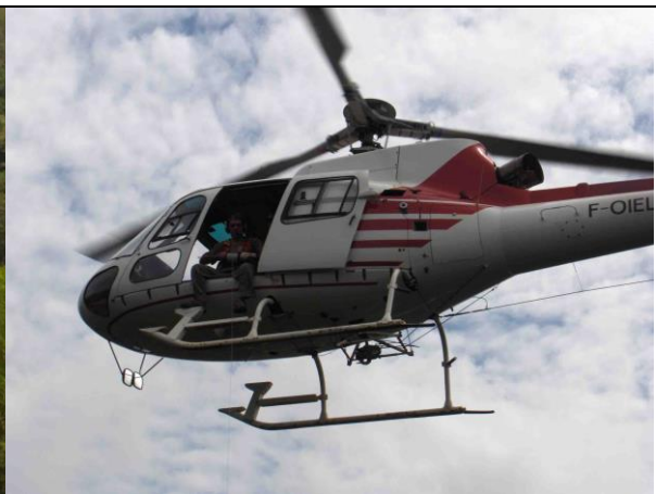
Déroutage d'une cordelette entre deux pylônes (14 septembre 2005)
