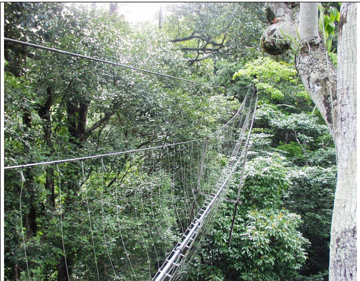
Passerelle situé entre la première et la seconde plateforme (février 2000). Remarquer, en premier plan, un dispositif en 'H', destiné à maintenir écartés les deux câbles porteurs (de tels dispositifs en 'H' étaient installés tous les 10 mètres). Le câble supérieur, indépendant, sert à la sécurité.
